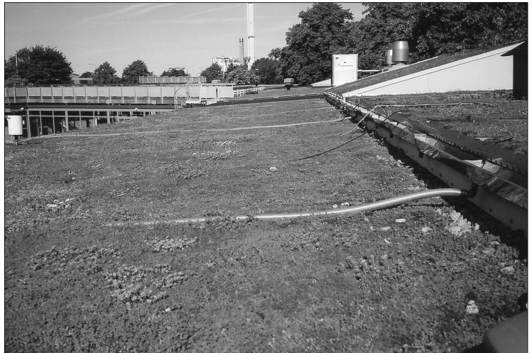
Figur 1. Grönt tak i Augustenborg, Malmö. Avrinningsvattenprover togs från en av sektionerna som ligger åt höger på fotot.
