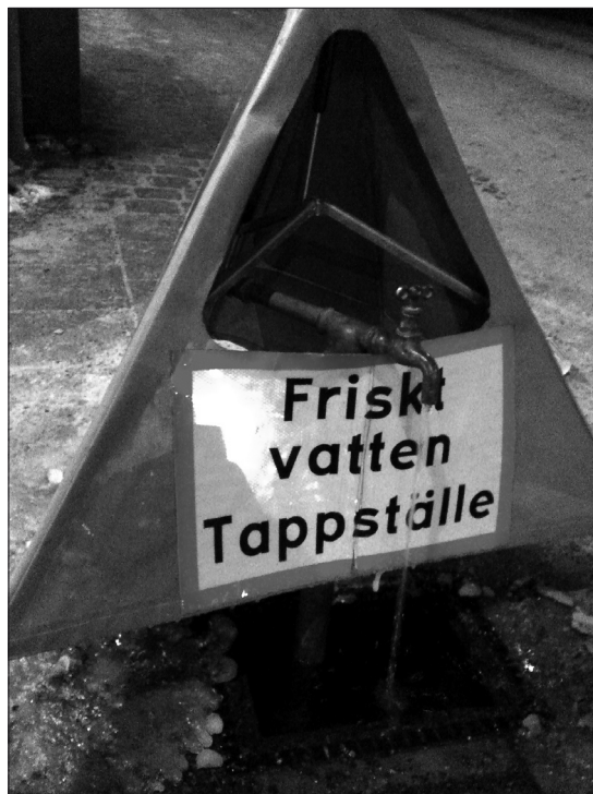
Figur 1. När den ordinarie dricksvattenförsörjningen inte fungerar måste kommunen ha en fungerande plan för nödvattenförsörjning. Här är ett tappställe för dricksvatten, Mariatorget, Stockholm. Foto Per-Erik Nyström.
