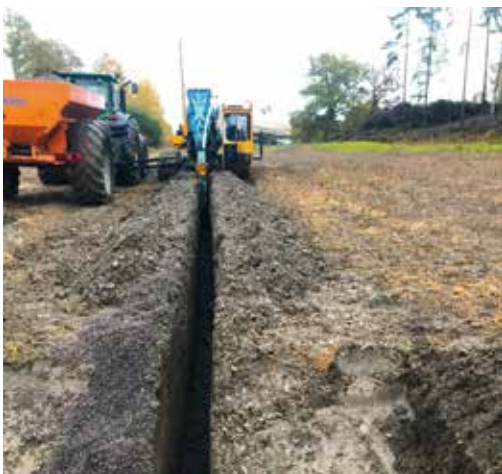
Figur 1. Pågående nedläggning av dräneringsslang för täckdikning. Fotograf: Markus Hoffmann
