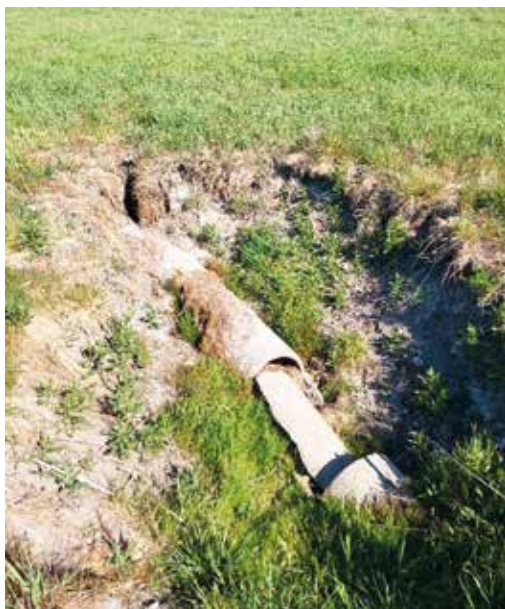
Figur 4. Kulvert som gått sönder av belastning från traktor eller tröska. Fotograf: Jon Wessling
