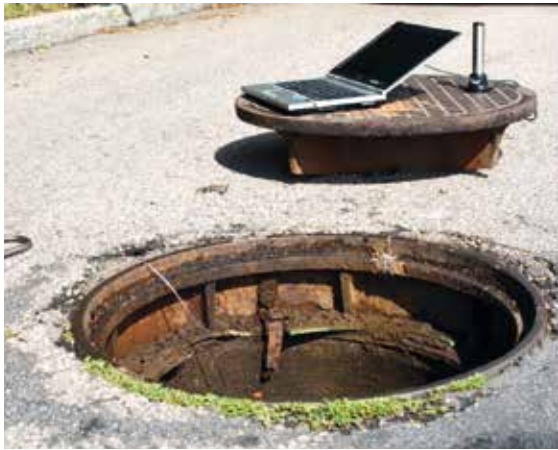
Installation av mätare i brunn
